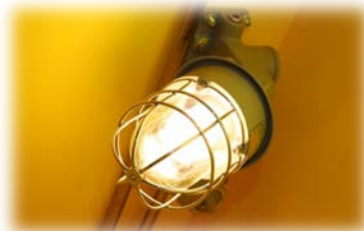
ВНУТРЕННЕЕ ОСВЕЩЕНИЕ (EXPROOF- взрывозащищенный) EX d IIB T4 – Ex tD A21 IP 65 T100 °C 230 V 100 W
