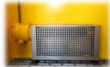
ЭЛЕКТРОНАГРЕВАТЕЛЬ (EXPROOF- взрывозащищенный) Eeex dIIC T3 230 – 400 V / 1000 W
